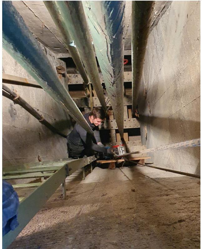
Luitpoldbrücke, Passau: Seilprüfung in Kavernen
