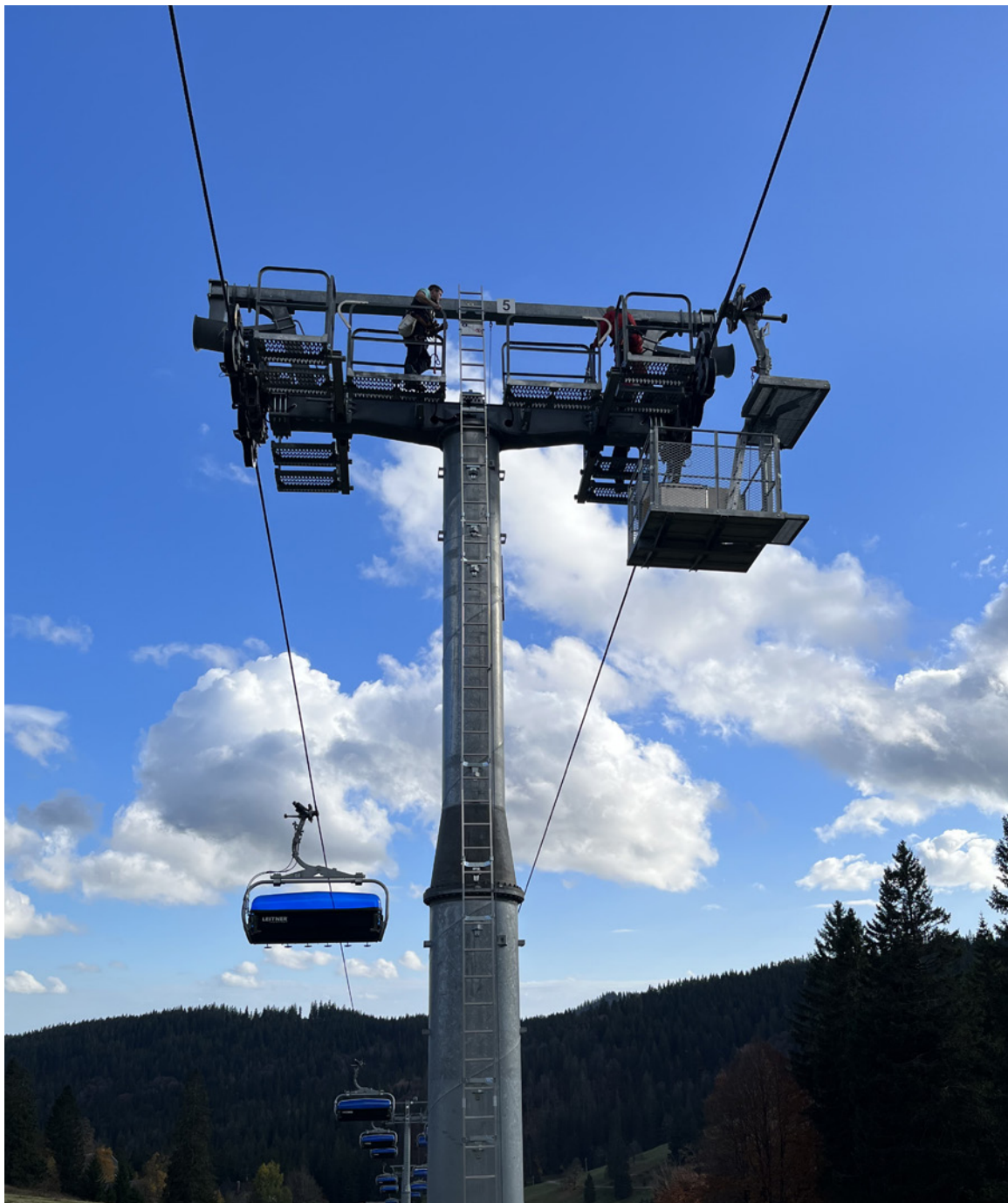
Prüfung einer Seilschwebbahn
