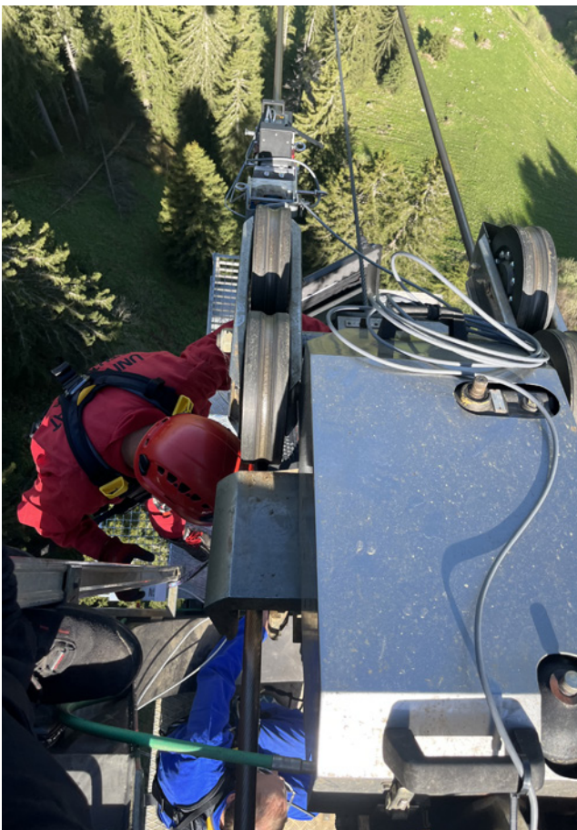
Die Grüntenseilbahn haben wir mit dem kombinierten magnetinduktiven und visuellen Seilprüfverfahren geprüft.
