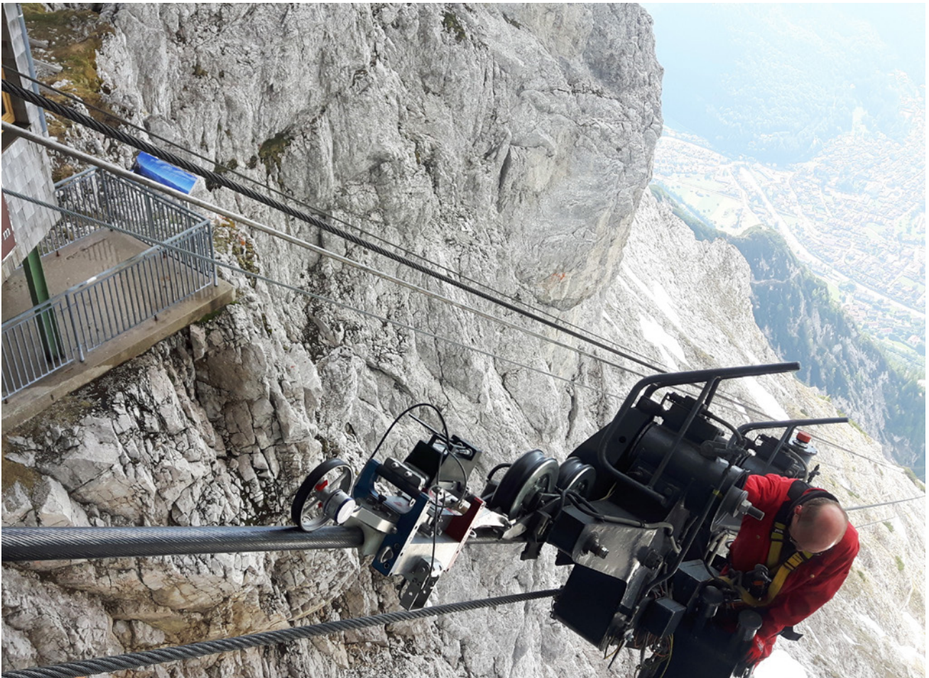
Karwendelahn, magnetinduktive Seilprüfung
