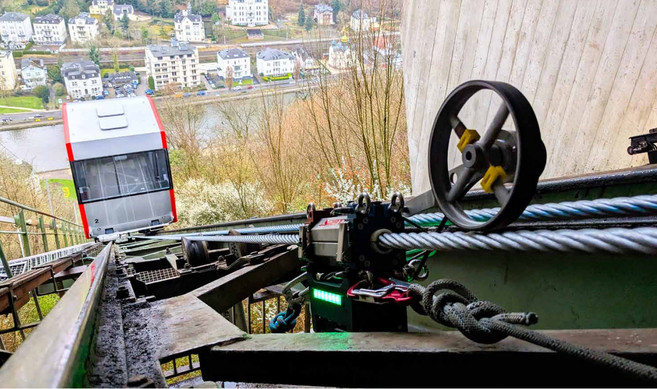
Magnetinduktive Seilprüfung von Standseilbahnen – Kurwaldbahn Bad Ems
