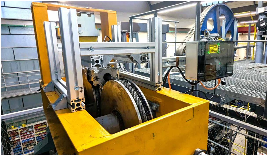
Einbauposition des Prüfgerätes am Mastkopf des RBG-Prüfstands mit seitlich montierter Elektronik
