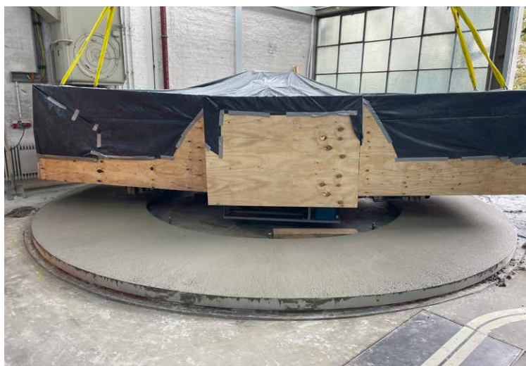
Vor der Inbetriebnahme musste der Spezialbeton aushärten.
