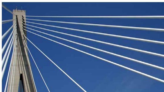
Abspannseile: Brücken- und Tragwerkskonstruktionen
