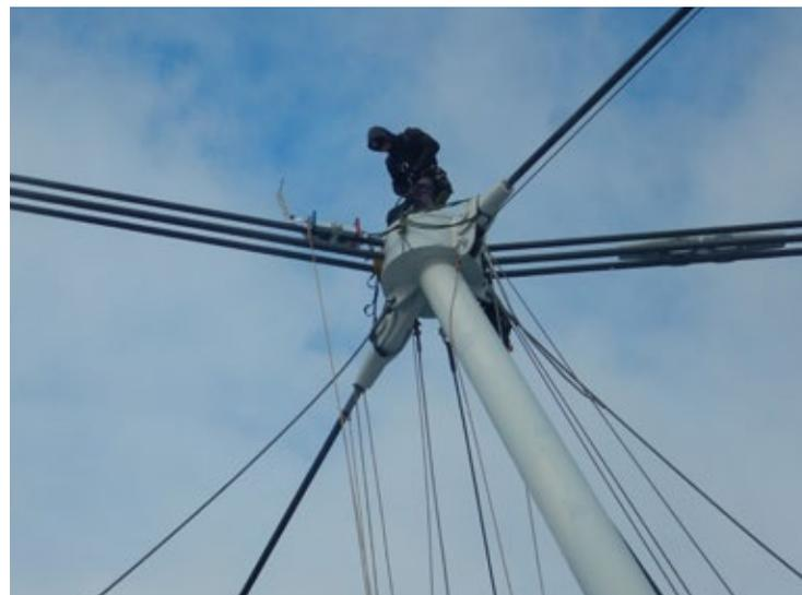
Magnetinduktive Prüfung der oberen Ringseile
