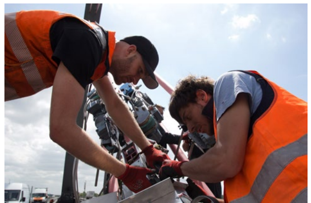
Die Ingenieure des IFT bei der Installation der Geräte
