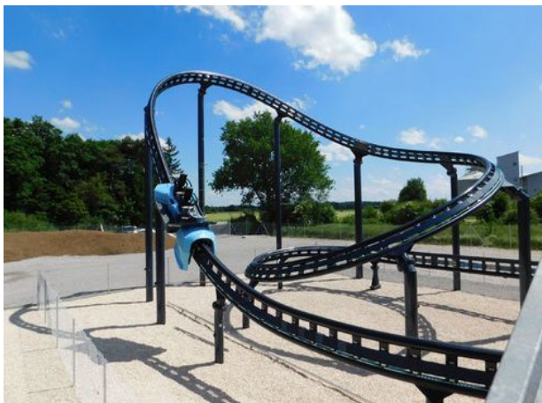
Die Achterbahn („Sky Dragster“) basiert auf der formschlüssigen Antriebstechnologie des HGFS
