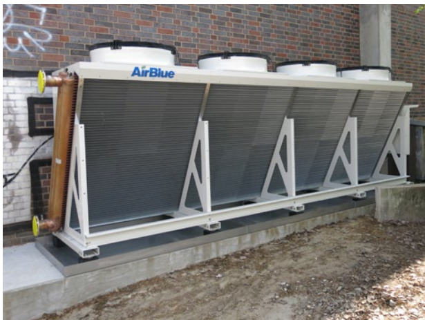
Kühleinrichtung für das Hydrauliköl im Außenbereich
