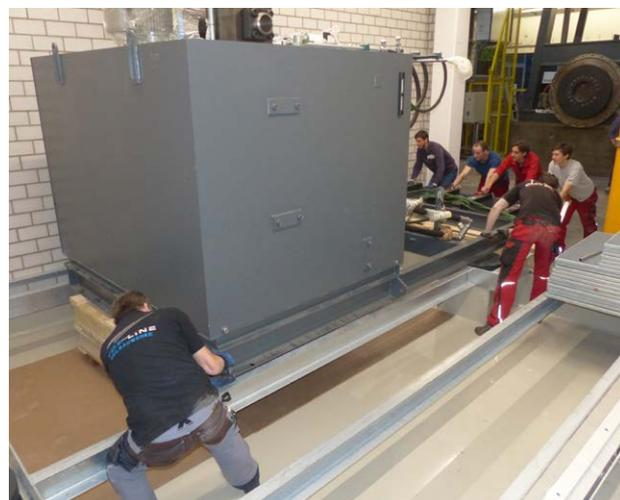
*Anlieferung und Einbau der neuen Hydraulikanlage einer großen Zugschwell-Prüfmaschine*
