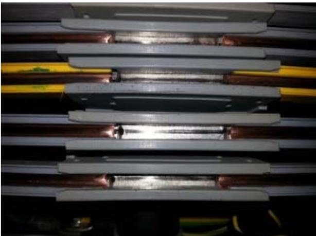
*Verbinder Stromschiene: Standardverbinder*
