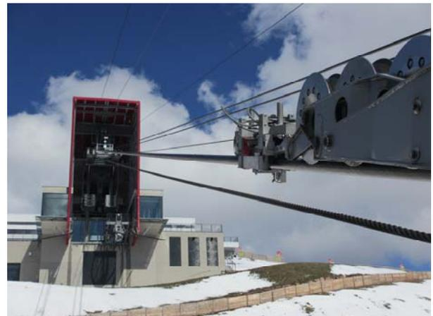
*Bild 13: Tragseilprüfung an der neu erbauten Pendelbahn „Meran 2000“, Meran, Italien*
