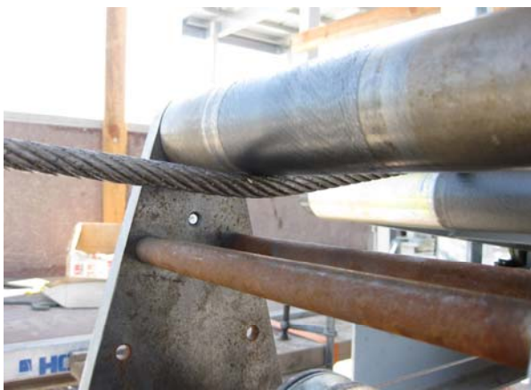
Bild 18: Begutachtung von Seilen und Seiltrieben vor Ort
