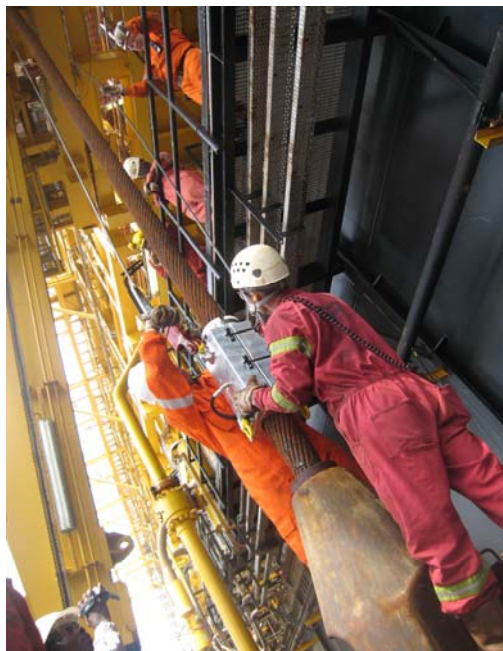
Bild 12: Vorbereitung der Seilprüfung des 120 mm Seils einer Seilwinde
