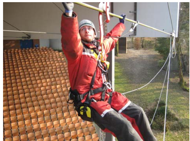
Bild 10: Mit Hilfe einer Seilrolle und eingehängtem Sitzbrett werden die anderen Unterseile begutachtet
