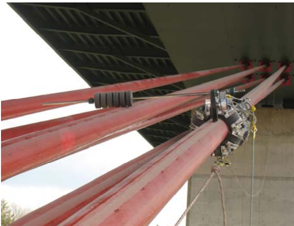
Bild 4: Prüfung der Unterseile der Autobahnbrücke „Obere Argen“ mit dem Prüfgerät SMRT 140
