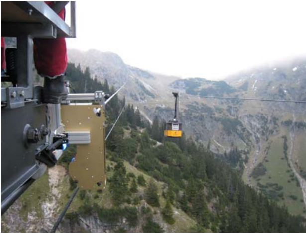
Bild 6: Tragseilprüfung mit dem digitalen visuellen Seilprüfgerät „Winspect“
