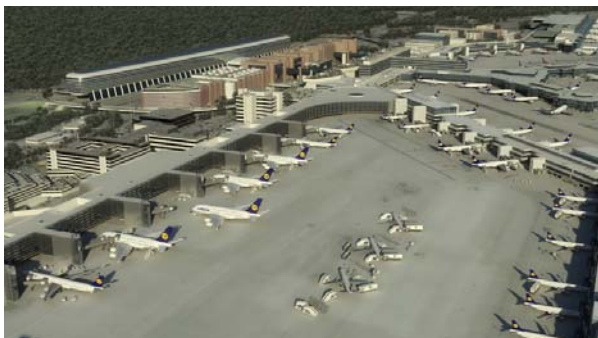
Bild 42: Terminal 3; Quelle Fraport AG
