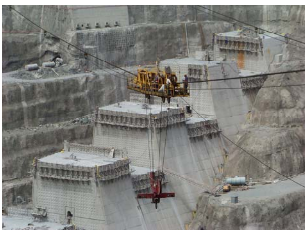
Bild 5: Kabelkran auf der Baustelle des Deriner Damms, Türkei
