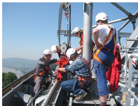
Bild 4: Montagearbeiten auf der Stütze der 3S
