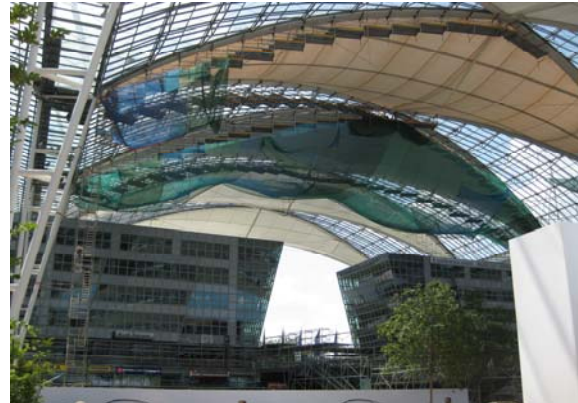
Bild 41: Das Forumdach am Flughafen München; Dachkonstruktion aus rautenförmigen Membranfeldern und Glasflächen
