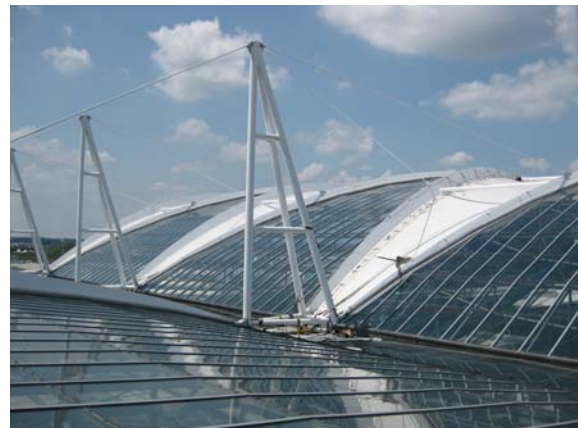
Bild 42: Detail der Dachkonstruktion, Blick von oben
