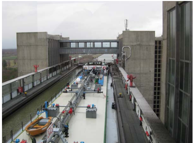
Bild 25: Schiffshebewerk Scharnebeck bei Lüneburg
