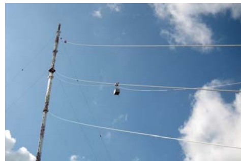
Bild 3: Prüfung der Abspannseile
