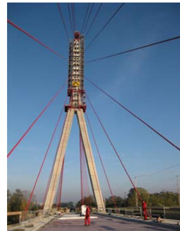
Abb. 6: Abspannseile der Elbebrücke Niederwartha Dieses voll verschlossene Trage-seil ist auf einer Seite an einem Mast fest abgespannt. Auf der anderen Seite wird es über eine Umlenkscheibe an einer auf dem Boden sitzenden Spannvorrichtung abgespannt. Durch kleine Schwingungen aufgrund des Fährbetriebs wird das Seil an der Umlenkscheibe permanent kleinen Biegewechseln ausgesetzt, welche auf Dauer zu einer Schädigung führen. Vor allem dieser Bereich muss regelmäßig geprüft werden.
