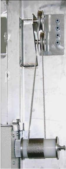
Abb. 14: Edelstahlseile in Teleskoptüren von Lackieranlagen
