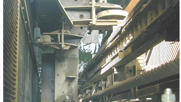
Abb. 13: Edelstahlseile in Schleusentoren
