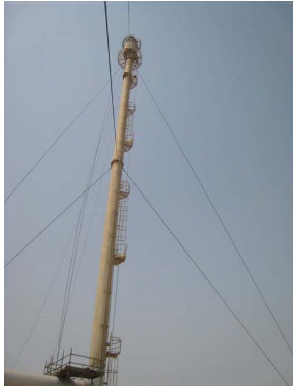
Abb. 9: Restgasverbrennungsanlage in Saudi-Arabien: „Flare“ mit Abspannseilen
