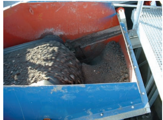
Abb. 20: Überschüttungen von Übergabestellen
