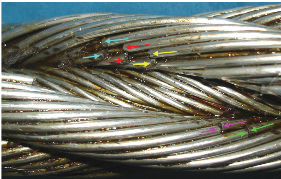
Abb. 16: Drahtbrüche bei einem Litzen-seil
