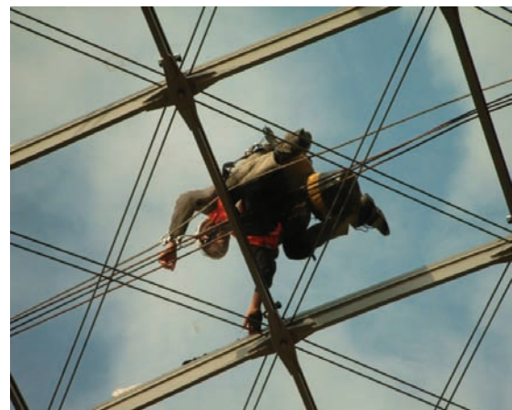
Abb. 41: Detail des Tonnengewölbes
