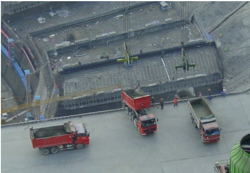
Abb. 26: Betonanlieferung mittels LKW
