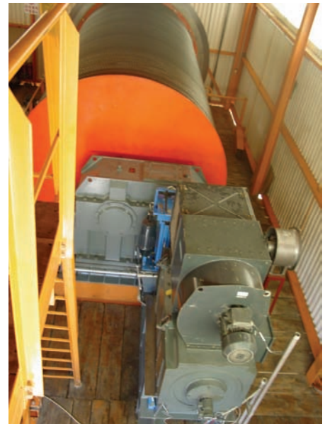
Abb. 27: Gleichstrommotoren des Hubwerkantriebs
