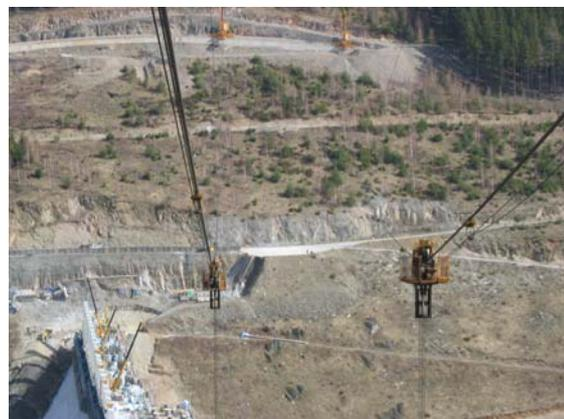
Abb. 7: Unterflasche mit Last (links) und Laufkatzen (rechts)
