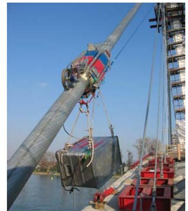
Abb. 22: Brückenseilprüfung
