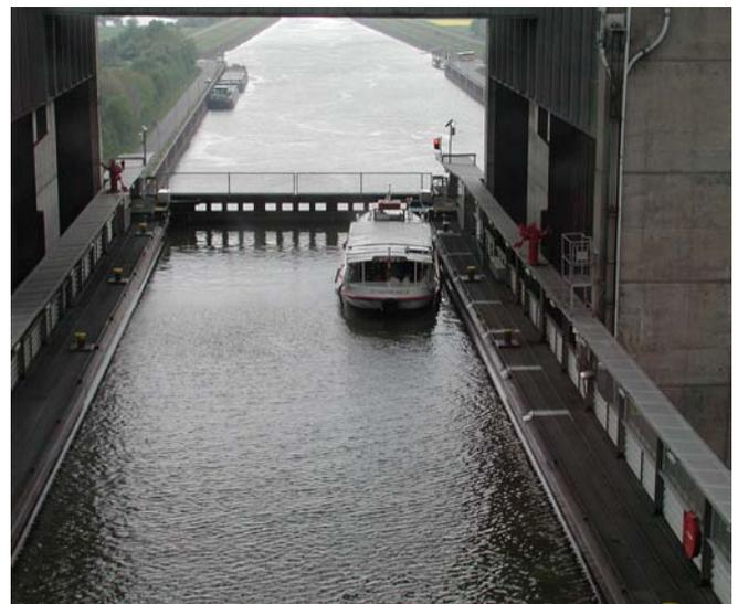
*Abb. 37: Trog des Schiffshebewerks Uelzen*
