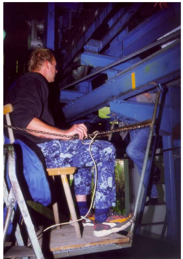
Abb. 29 Gegenwärtig durchgeführte visuelle Seilkontrolle
