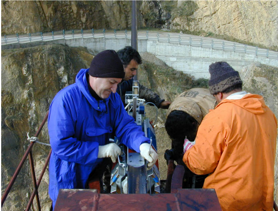
Abb. 27 Seilprüfung des Kabelkrans im Iran
