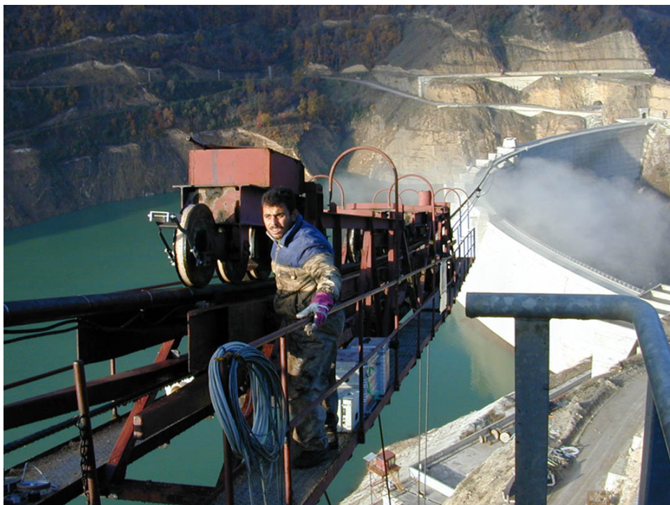
Abb. 26 Kabelkrananlage im Iran
