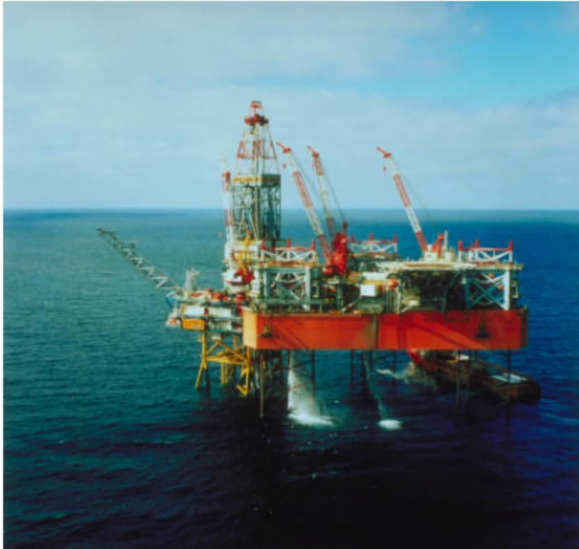
**Bild 15** Bohrinsel in arbeitsbereiter Position, die Stützen sind ausgefahren
