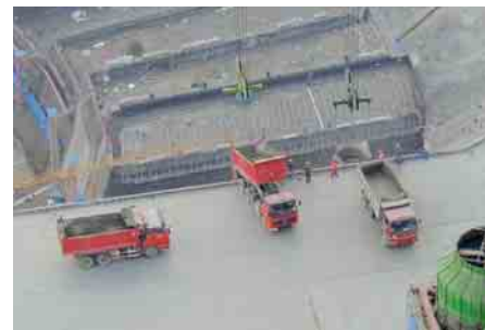
6 Beladung der Transportkübel mit Beton (Fassungsvermögen 30 t)
